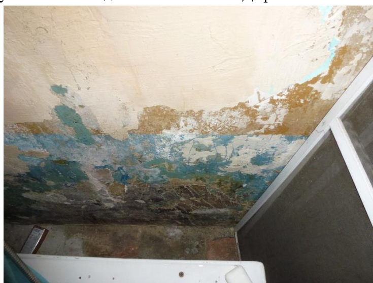
Фото 5. Наружная стена в помещении санузла.
