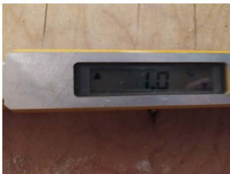
Фото 20. Отклонение напольного покрытия от заданного уклона.
