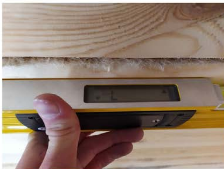
Фото 7. Отклонение венца из бруса от горизонтали на 1 м.
