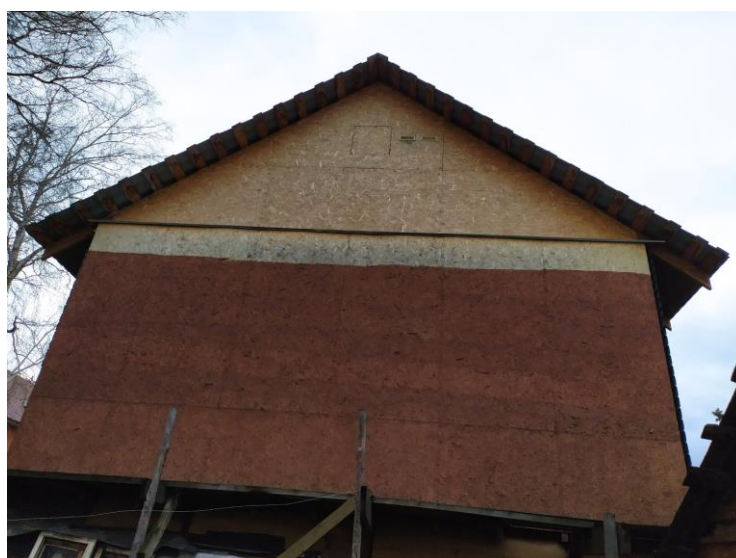
Фото 2. Фрагмент вида фасада.
