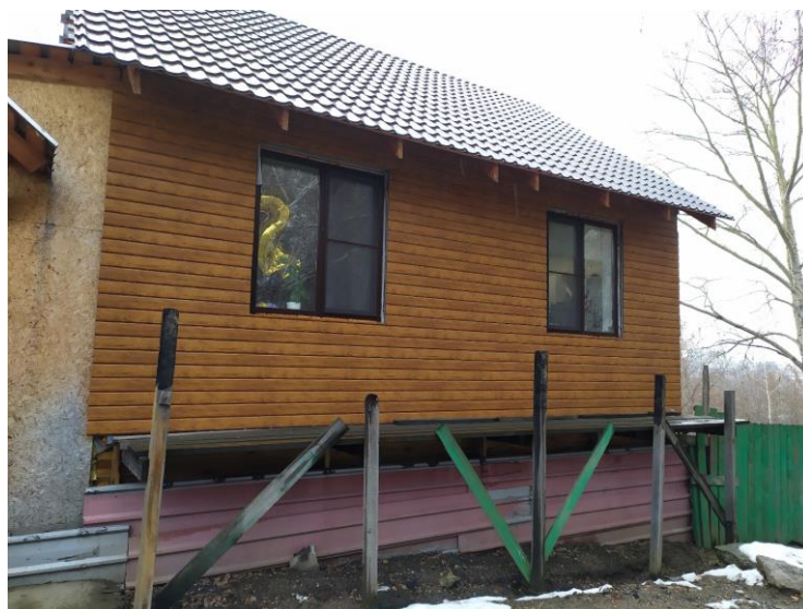
Фото 1. Фрагмент вида фасада.
