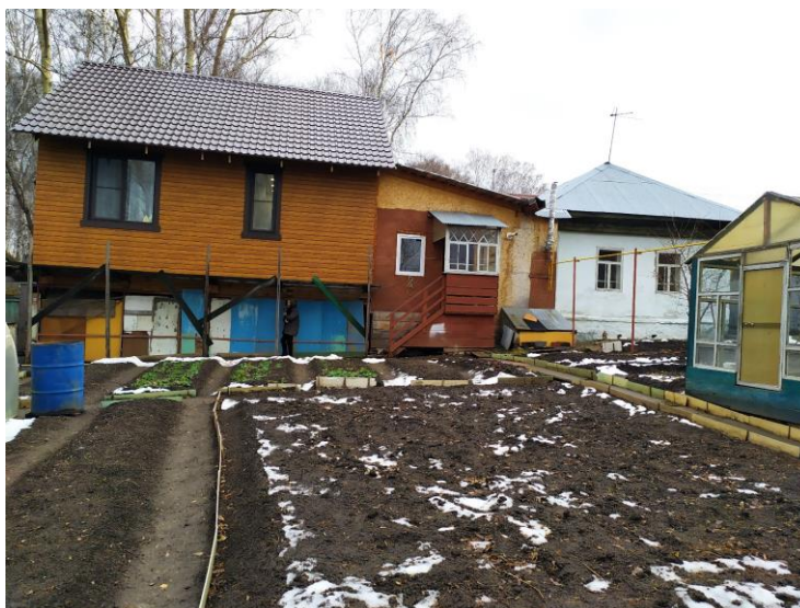
Фото 4. Фрагмент вида фасада.
