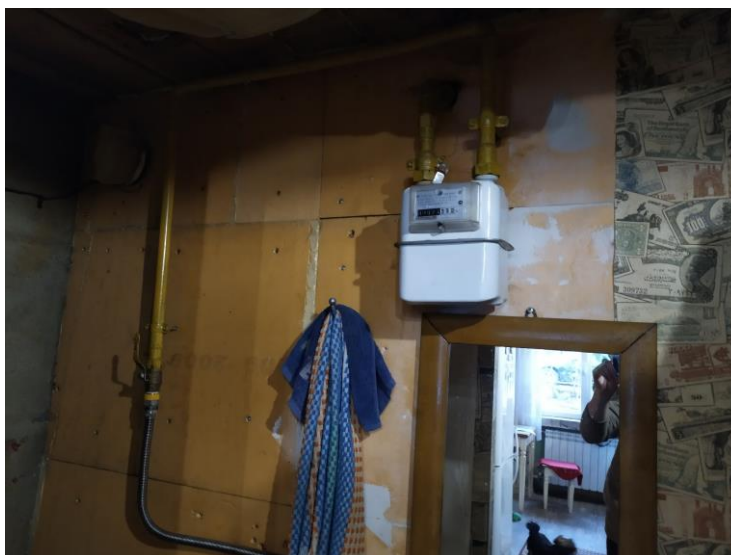
Фото 5. Фрагмент вида помещения.
