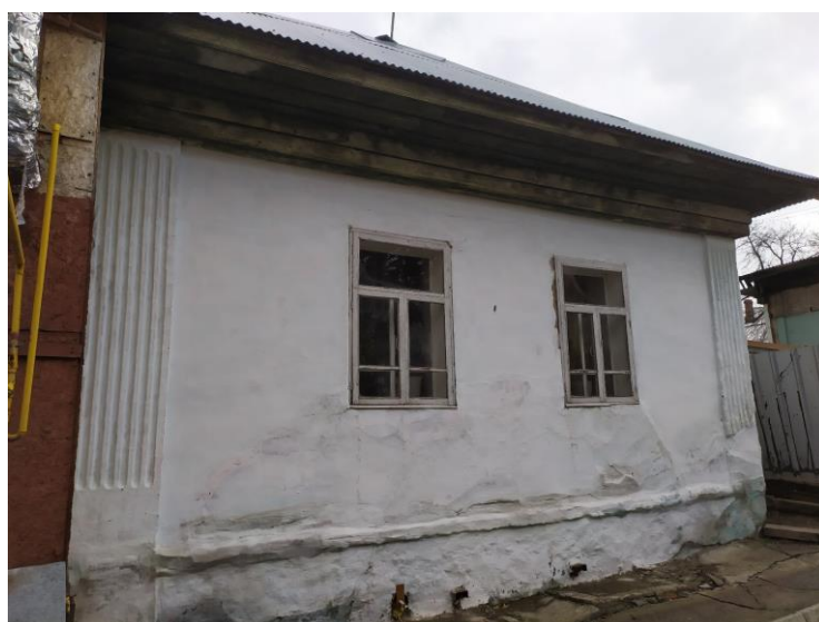
Фото 3. Фрагмент вида фасада.
