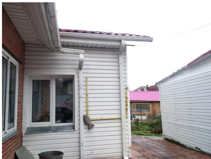
Фото 4. Фрагмент вида фасада.
