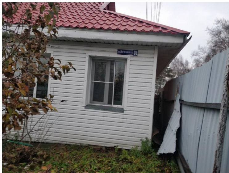
Фото 1. Фрагмент вида фасада.
