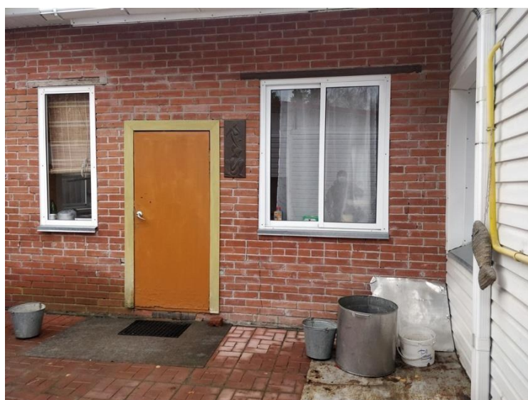
Фото 3. Фрагмент вида фасада.
