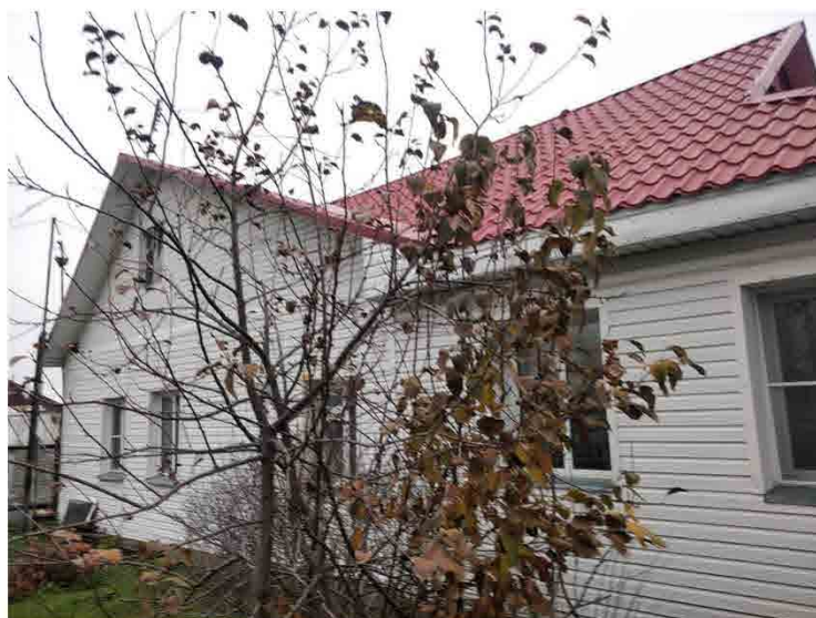
Фото 2. Фрагмент вида фасада.
