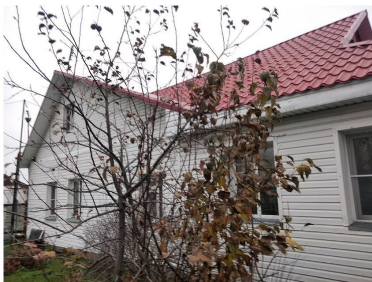
Фото 2. Фрагмент вида фасада.
