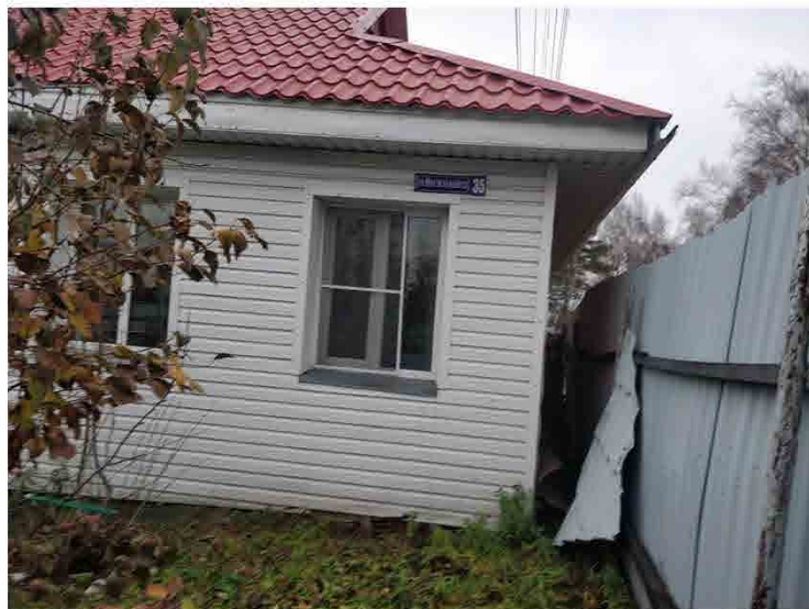
Фото 1. Фрагмент вида фасада.
