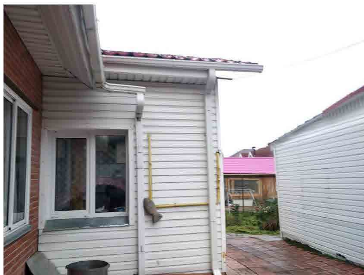
Фото 4. Фрагмент вида фасада.
