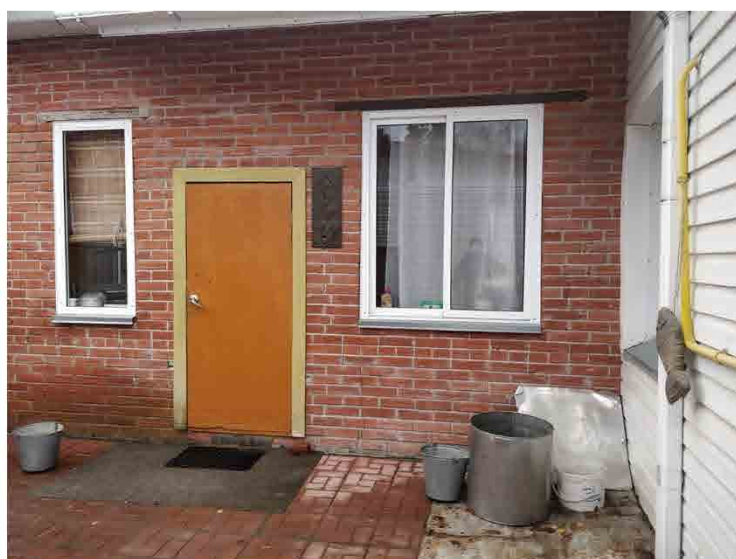
Фото 3. Фрагмент вида фасада.
