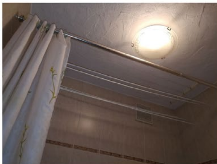
Фото 16. Фрагмент вида помещения
